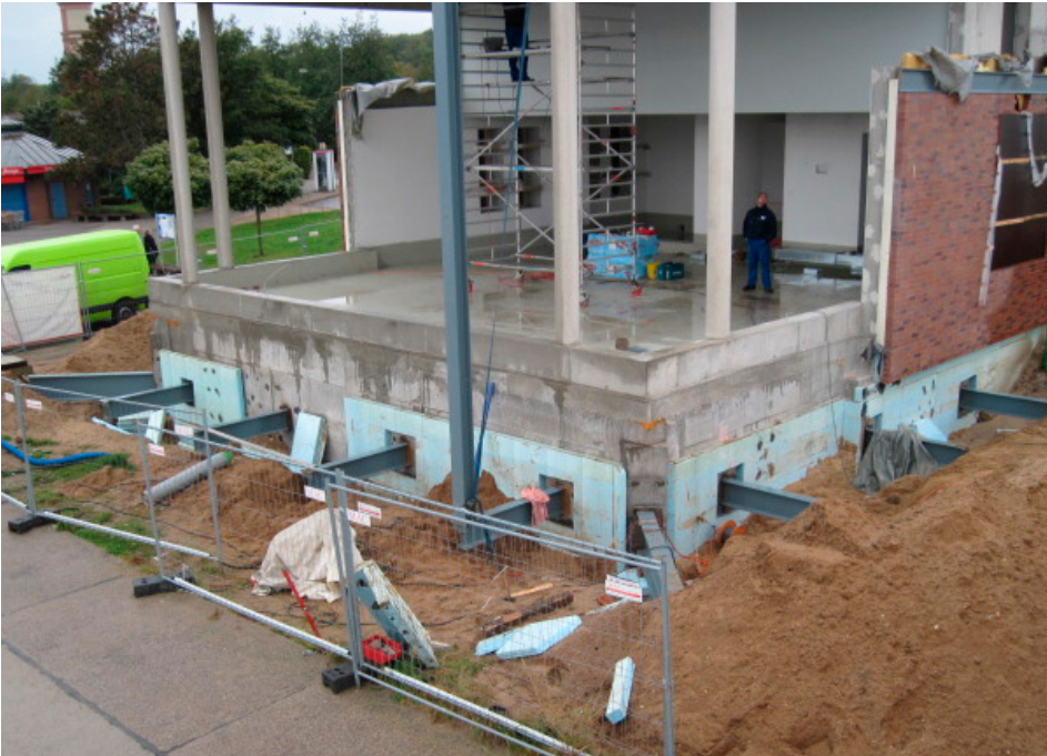
Abb. Kragarme mit der ersten Stütze
