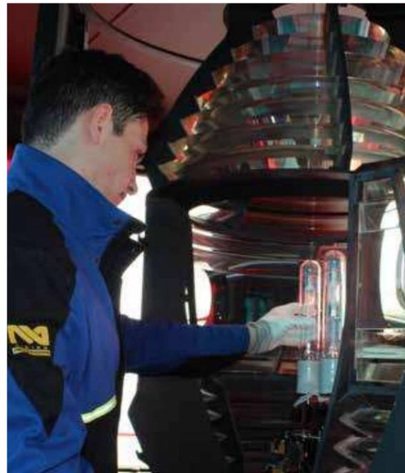
Probe liefen, das Funkfeuer abgeglichen wurde, die Optik und Verglasung musste gereinigt werden. Die Funkanlage, welche für die Übertragung der Stationsmeldungen von Nöten war, wurde nachgeregelt und der Tausch der Leuchten der Molenanstrahlung wurde mit akrobatischen Leistungen vollbracht. Es gab noch viele weitere Aufgaben, aber alles hier aufzuführen, würde den Rahmen sprengen.
