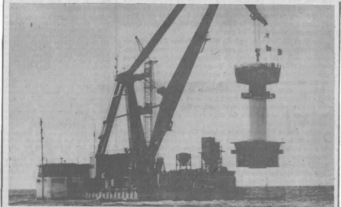
Zwanzig Minuten nach zwölf Uhr mittags wurde gestern der Schaft des neuen Leuchtturms vom Kran auf den Molenkörper hinübergehievt (Bild oben). Zwei Stunden später, um 14.20 Uhr, war der Turm mit dem Fundament fest verbunden (unten). Zwischen Leuchtturmschaft und Umbau ist ein zehn Zentimeter breiter Hohlraum, damit der Aluminiumturm bei Sturm Spielraum hat. (Fotos: A. Kroeker)
