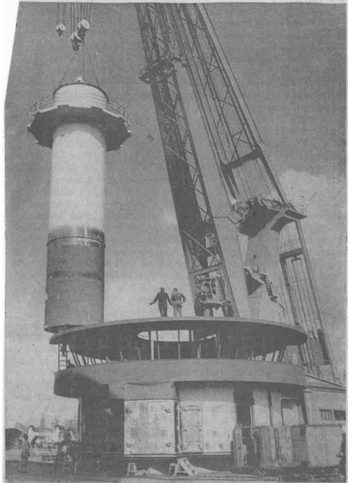
DAS GAB ES NOCH NIE IN KIEL: Ein Leuchtturm schwebt durch die Luft. Der Turmschaft, mit Kopf und Leuchte wird er 35 Meter hoch, wurde gestern vom Schwimmkran „Magnus I“ zur Vormontage in den fünf Meter hohen Umbau eingesetzt. Mitte Oktober soll die Aluminiumkonstruktion der Firma Ambau die Reise über See zum Leuchtturmfundament in der Außenförde antreten. (le) (Foto: Kroeker)
