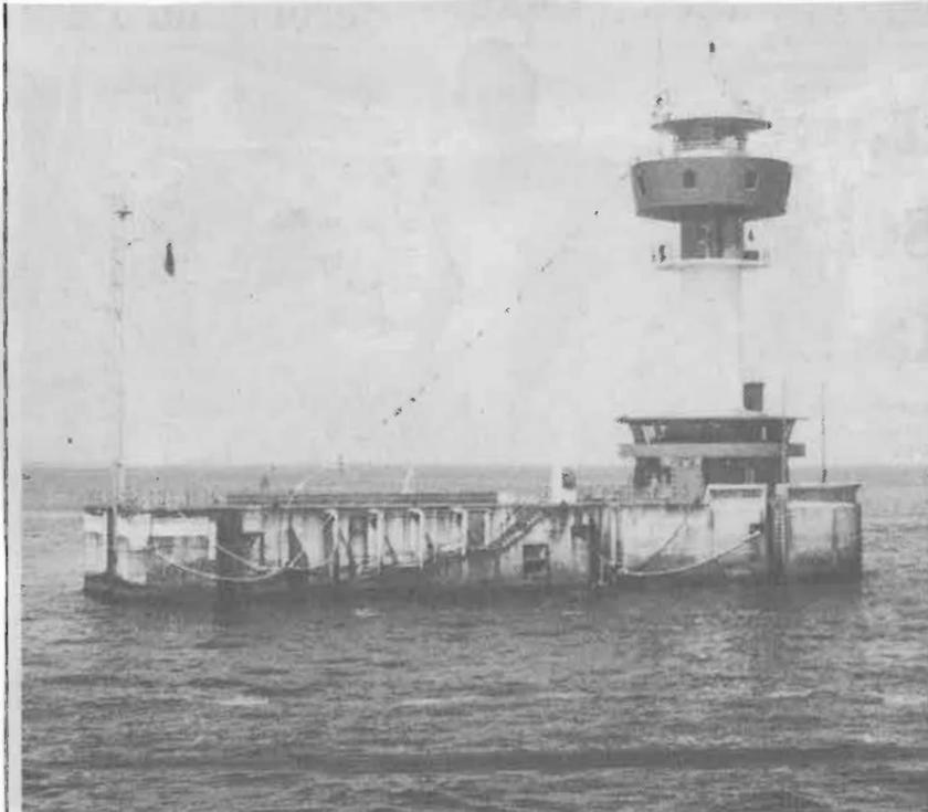
Der Leuchtturm Kiel steht seit 25 Jahren. Die rechtwinklig angelegten Betonkästen sollen den Lotsenversetzbooten bei jeder Windrichtung ein sicheres Anlegen ermöglichen. Foto har
