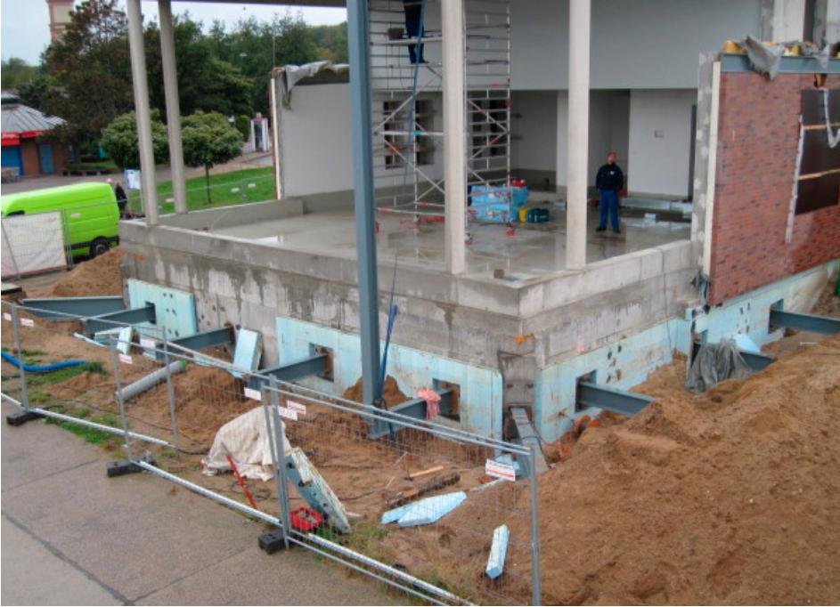
Abb. Kragarme mit der ersten Stütze
