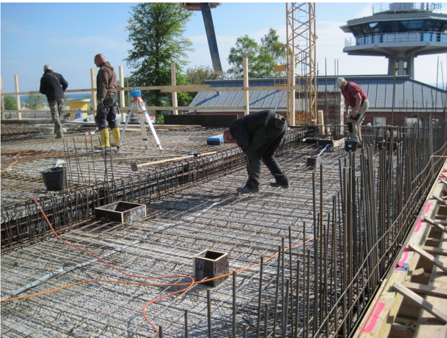
Abb. Bewehrung der Obergeschossdecke
